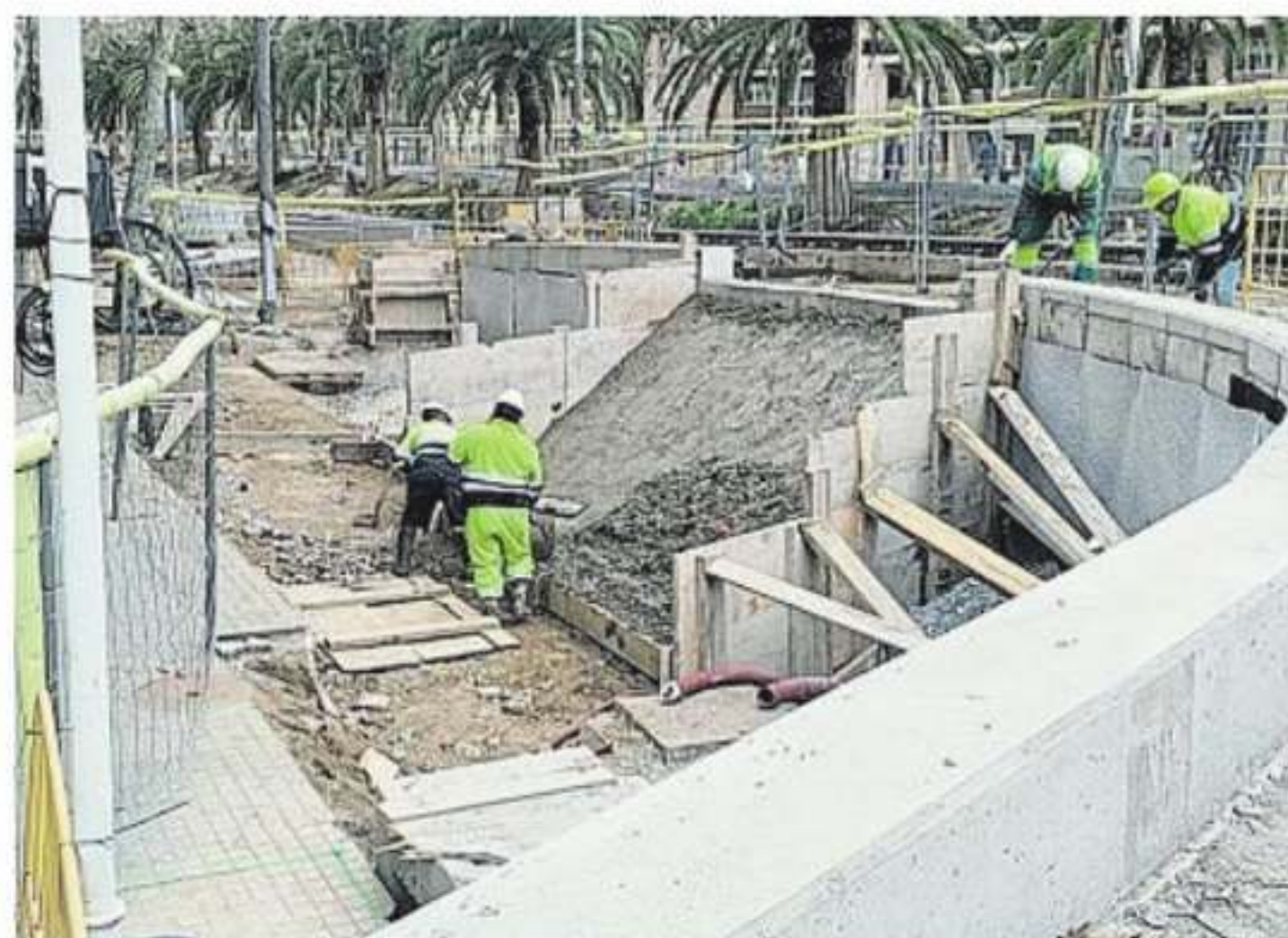
Las obras de las polémicas escaleras, hace unos pocos días
